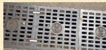
ちなみに排水溝の蓋も 東大オリジナルです。
